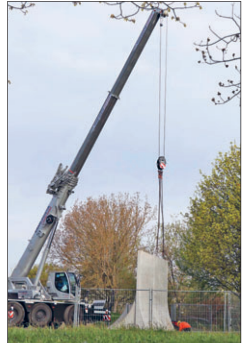
Die große Wand (Wall) ist 4 Meter hoch und musste mithilfe eines Autokrans gesetzt werden.
